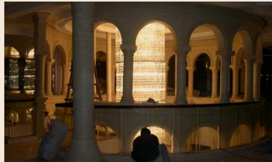
2007年12月东部华侨城花园酒店紧张施工中
